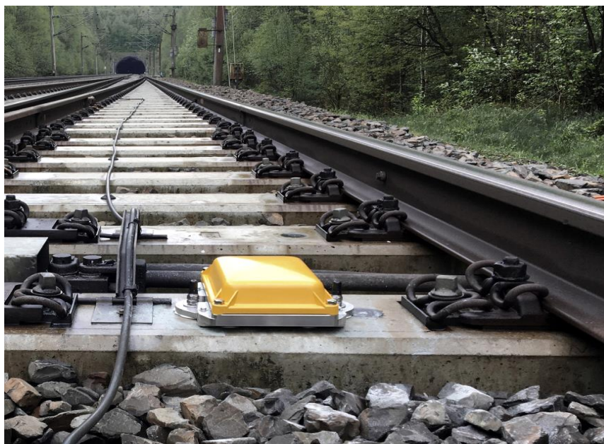
1.8-сурет – Инфрақұрылымды болжамды бақылау үшін теміржолға орнатылған KONUS сенсоры
